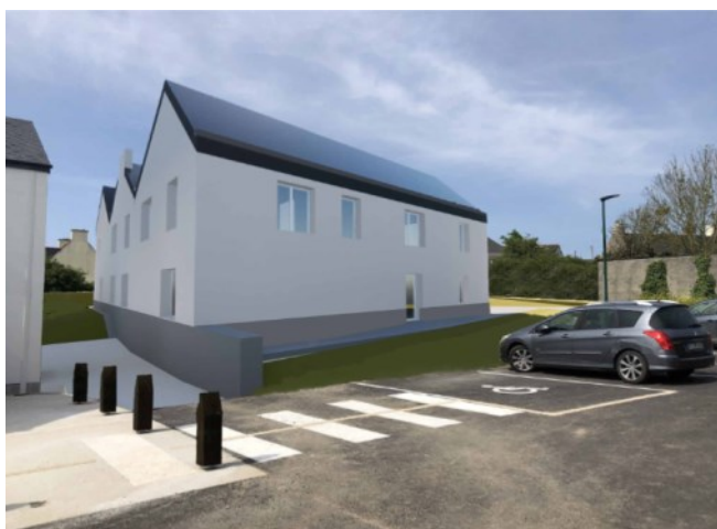
Les travaux de construction du 4 ème bâtiment de la maison de bien-être doivent débuter prochainement
