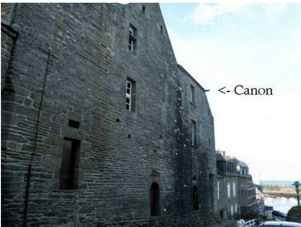
5 - Le Conquet, rampe des Lombards : canon de pierre en haut d'un rempart
