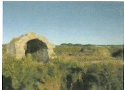
L'édifice présente les mêmes caractéristiques que le corps de garde : construction en pierre de taille de granite, mortier de chaux, enduit de chaux. Les archives consultées attestent la présence d'une voûte. Si l'on en juge par les élévations conservées, ce bâtiment pouvait être du même type que celui de la batterie de Saint-Eden à Plouescat (cf. restitution p. 9).
